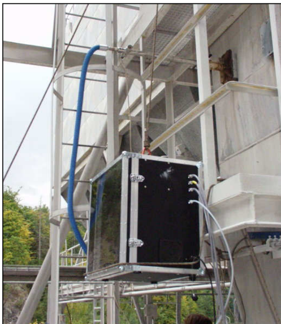
Odběr vzorku z potrubí do manifoldu vzorkovače
