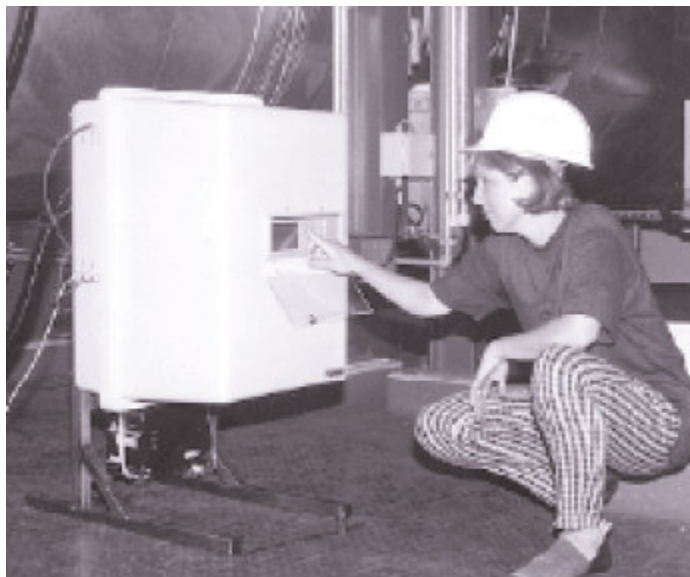
Instalace přístroje SM-3 ve spalovně komunálních odpadů
