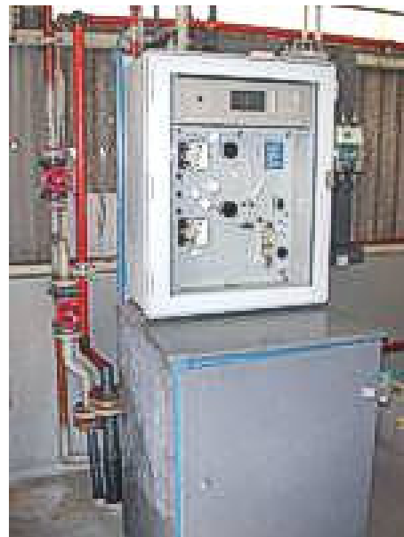
Přístroj PA-1 pro kontinuální monitoring rtuti na výpusti v závodě na výrobu chloru a alkálií
