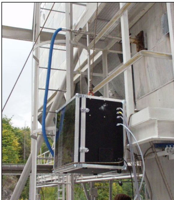
Odběr vzorku z potrubí do manifoldu vzorkovače
